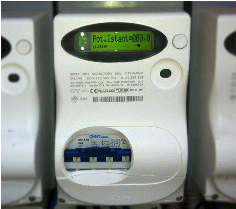
*Il contatore della luce ci fornisce il valore della potenza elettrica assorbita in un dato momento da tutti gli apparecchi utilizzati in una casa.*
