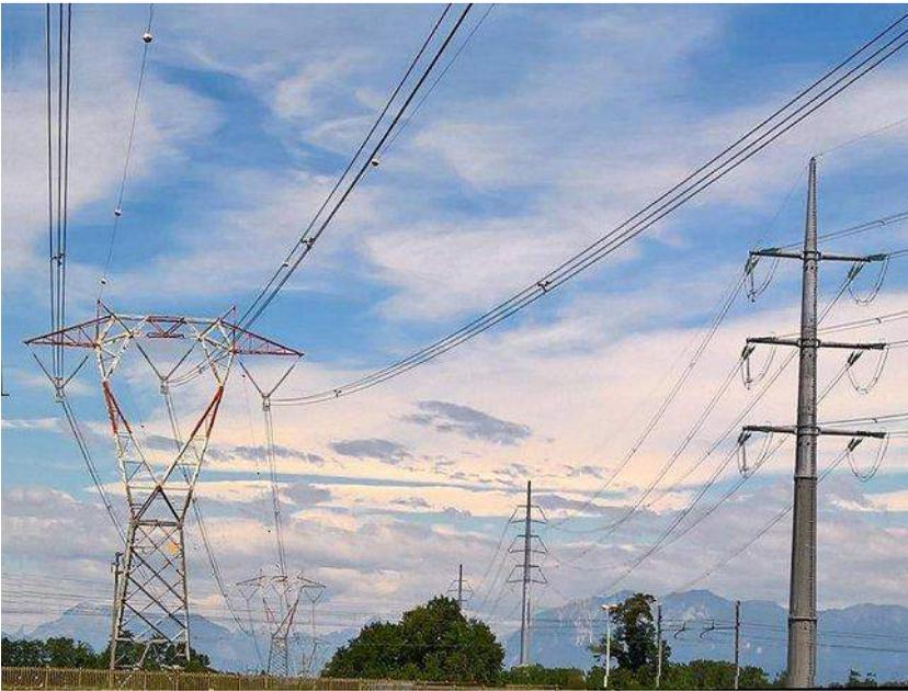
*Linee a 380 kV italiane con i nuovi tralicci monostelo e quelli del vecchio tipo.*
